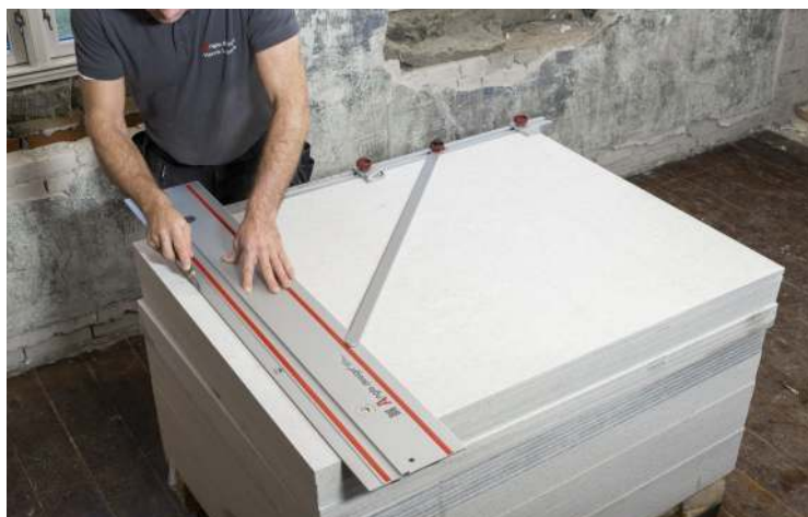
2. Ved skæring med kniv vendes føringsstakken og den modsatte side anvendes. Den fastsatte mållinje passer fortsat selvom føringsstakken vendes.
