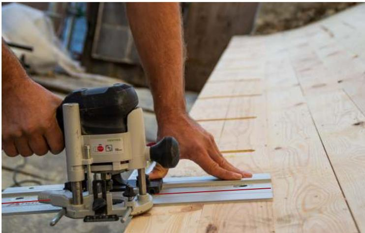
11. Jetzt ist es ganz einfach, die restlichen Ausfräsungen vorzunehmen. Es empfiehlt sich, an der Führungsschiene eine kleine Linie zu setzen, an der die Oberfräse geführt werden muss, um die gewünschte Länge der Ausfräsung zu erhalten.
