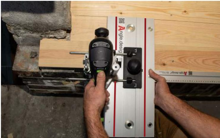
9. An Brandmauer oder Traufe einmessen, die Hauptschiene an den Dachrand legen und die erste Nut fräsen.
